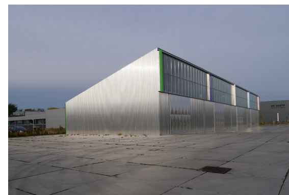
VOORBEELD VAN EEN BIJZONDERE DAKVORM ALS DEEL VAN DE ARCHITECTUUR (WAREGEM)
