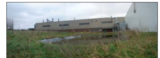
Foto: bestaande zuidoostelijke loods
