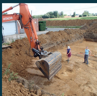
Voor de uitbreidingswerken van het bedrijventerrein Wevelgem Zuid van start gingen, voerden archeologen onderzoek op de site.
