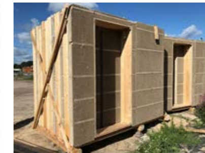
Bio-gebaseerde gevelpanelen uit hennep en stro. Ze worden geprefabriceerd en losmaakbaar geïnstalleerd.
