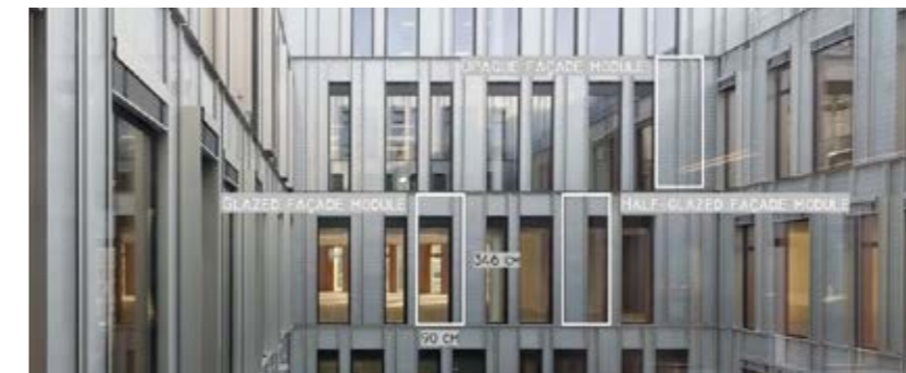
Losmaakbaar, bio-gebaseerd gevelpaneel in project Aeropolis II te Brussel, door Architectes Associés.
