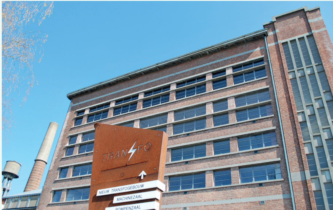
Herbestemming Nieuw Transfogebouw
