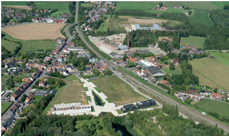
Reconversie Bramier Lauwe (Mene) ©Luchtfotografie Henderyckx
