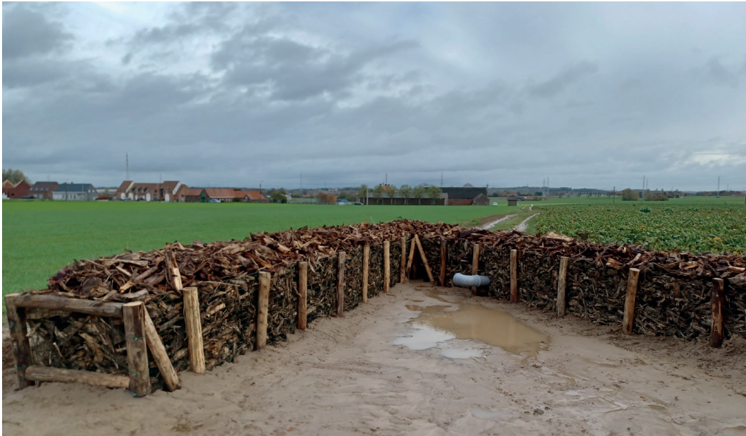
PDPO klimaatadaptatie: houthakseldam Zwevegem
