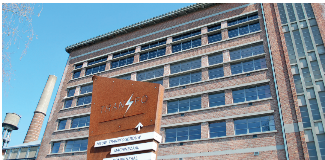
Herbestemming Nieuw Transfogeboew
